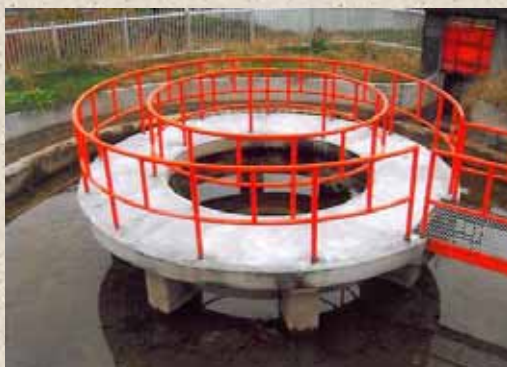
円筒分水工 水を必要な系統ごとに分岐させる。
