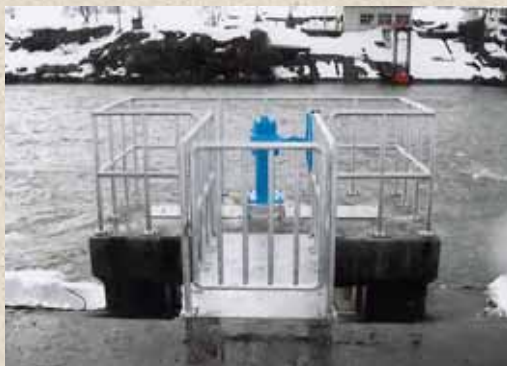
水門 川より水を取水する入り口となる。
