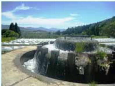
雉子ヶ沢揚水機場吐出水槽
